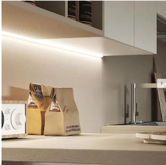
LED bajo mueble alto de cocina Perfil con iluminación LED bajo mueble alto de encimera. Accionamiento mediante tecla incorporada a los mecanismos de la vivienda.
